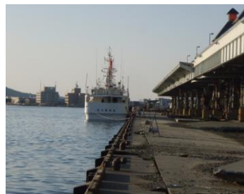
地震により70cm以上沈下
